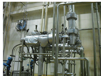
蒸気バルブ等の保温化対策
