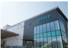
▲ JR東日本クロスステーション みなかみプラント
