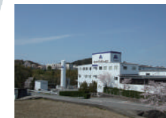
▲ 和歌山プラント
