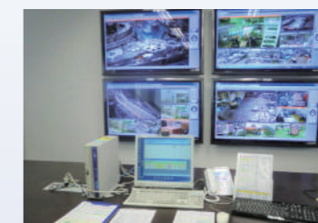
▲ コントロール室完成
