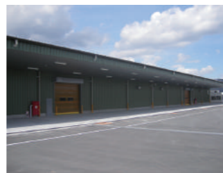
▲ 棟東物流・倉庫
