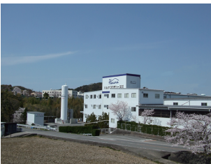
▲ 和歌山プラント
