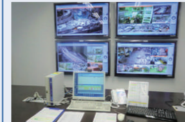
▲ コントロール室完成
