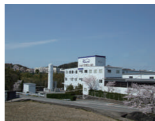
▲ 和歌山プラント
