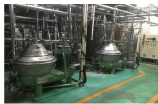
遠心分離機インバーター更新 (第2プラント)
