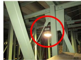
自動倉庫内照明のLED化(タニガワP)
