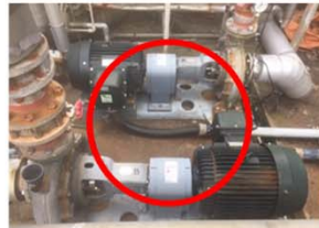
原水ポンプのインバーター化(タニガワP)
