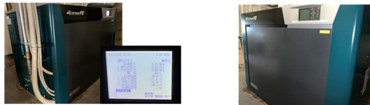
コンプレッサーをインバーター機へ更新 (ハルナプラント)
