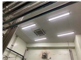
第3Pのろ過室照明のLED化 (ハルナプラント)
