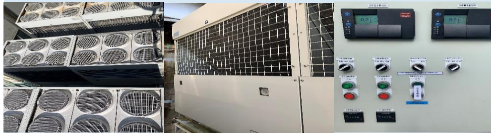
アイスビルダー (ファン) (冷凍機本体) (操作盤)
